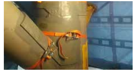
3. Wiederaufbau und Reparatur
