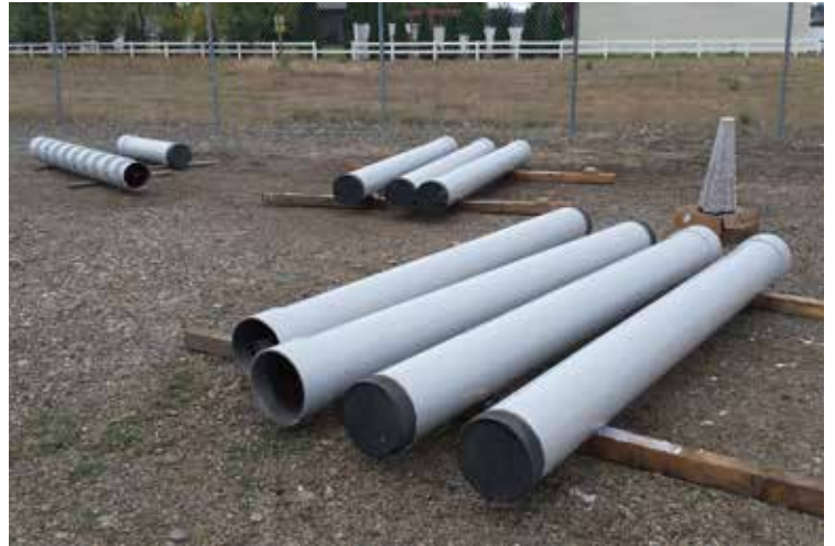
Belzona 5811DW2 für 40 Jahre alte Bewässerungspumpe
